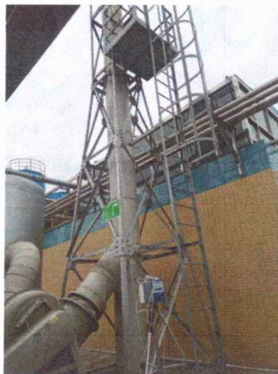
污水处理站排气筒出口 05#
